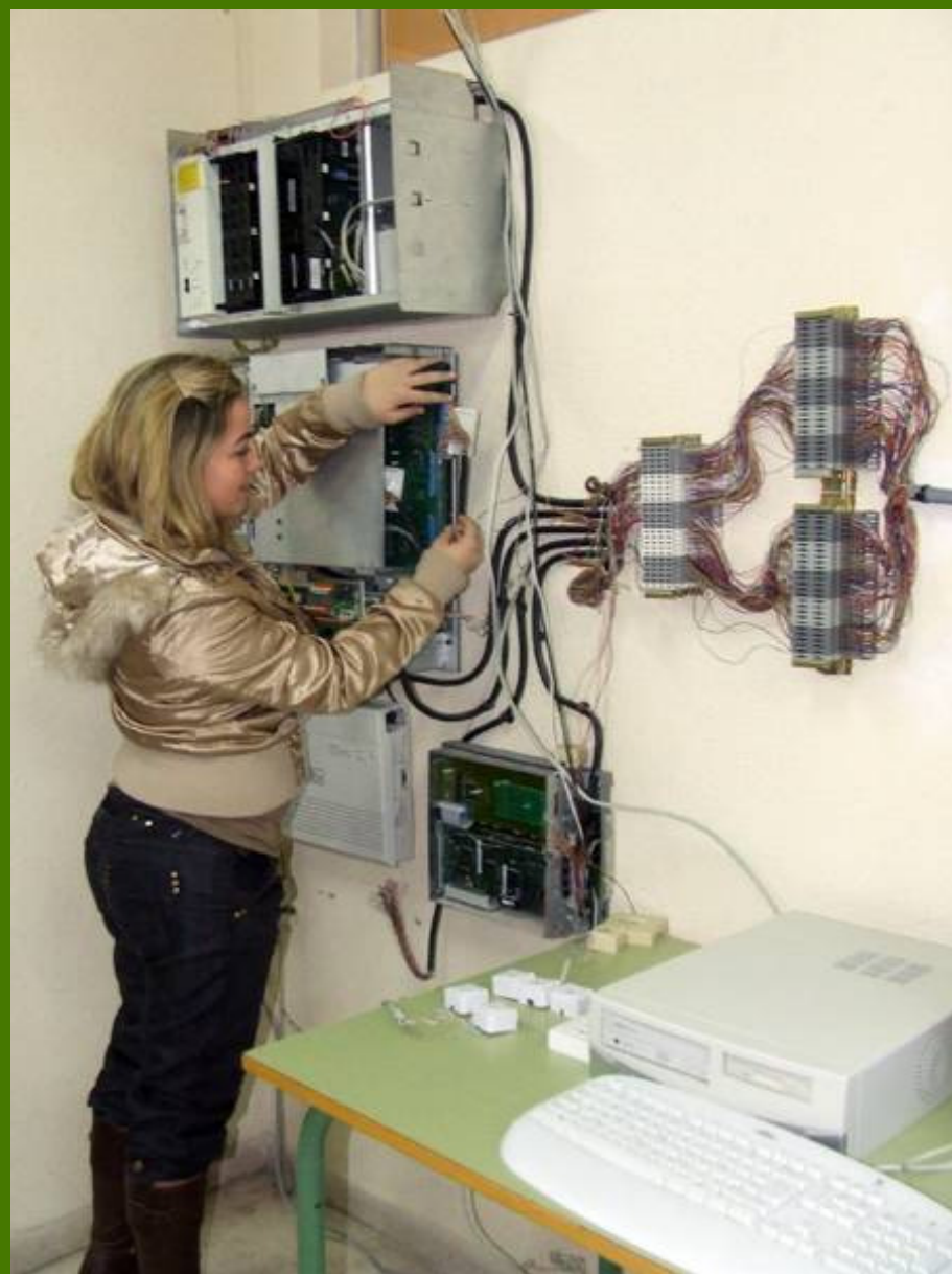
Instalación de centrales de telefonía
